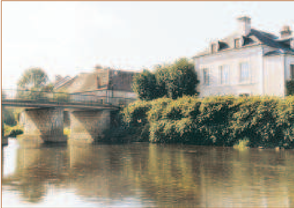
Le pont sur l'Indre.
